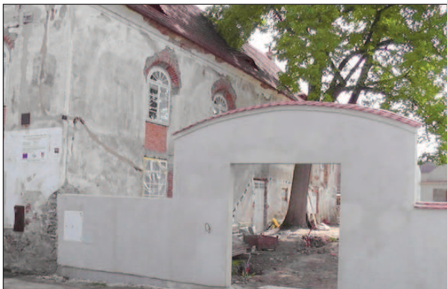
Práce na synagoze zdárně pokračují.
